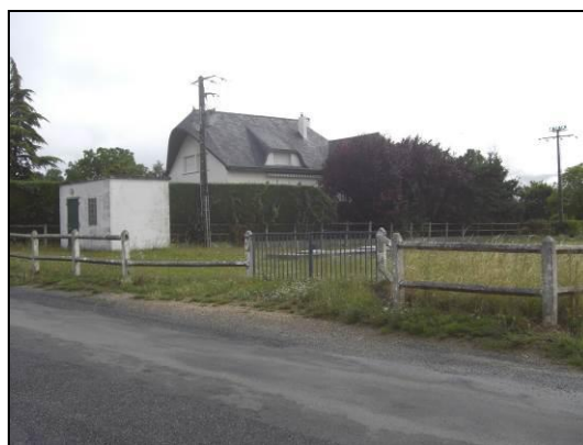
Vue sur le périmètre de protection immédiate
