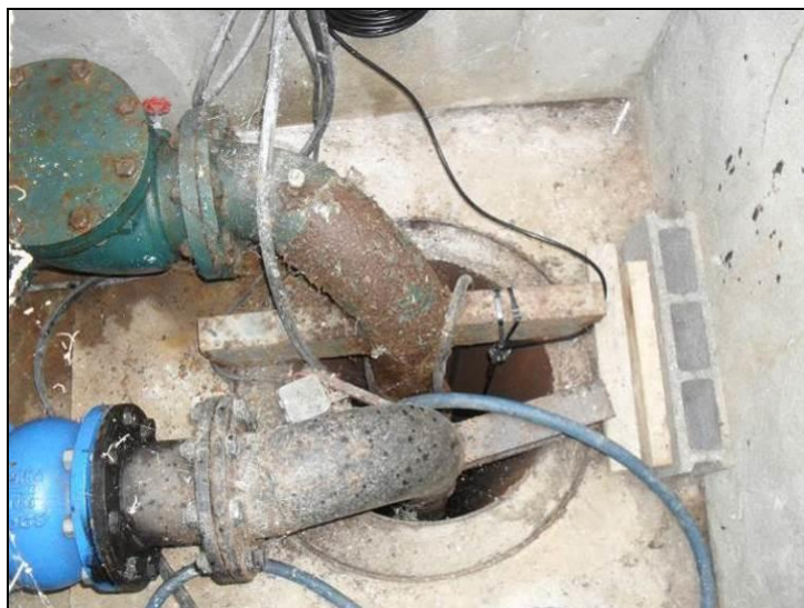
Photographie 7 : Vue sur la tête du captage
