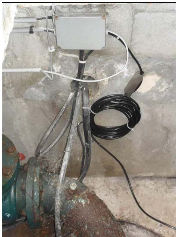
Photographie 13 : Évacuation câbles électriques de la chambre
