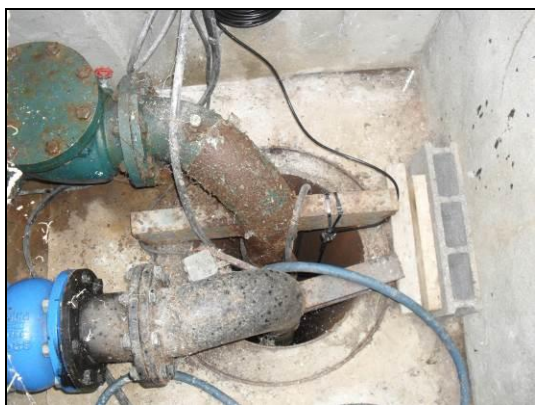
Tête de puits du captage
